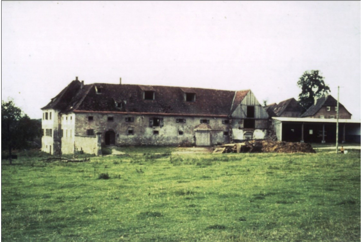
Abb.14: Der Nordflügel des späteren Gestüts in den 1960er Jahren
