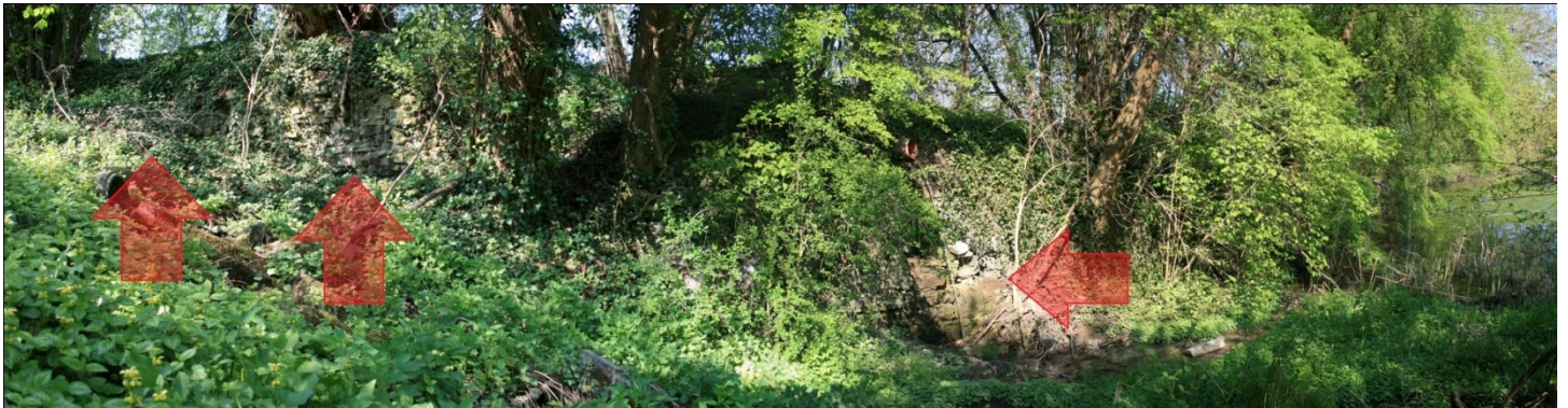
Abb.5: Aufgehendes Mauerwerk der südlichen Außenmauer
