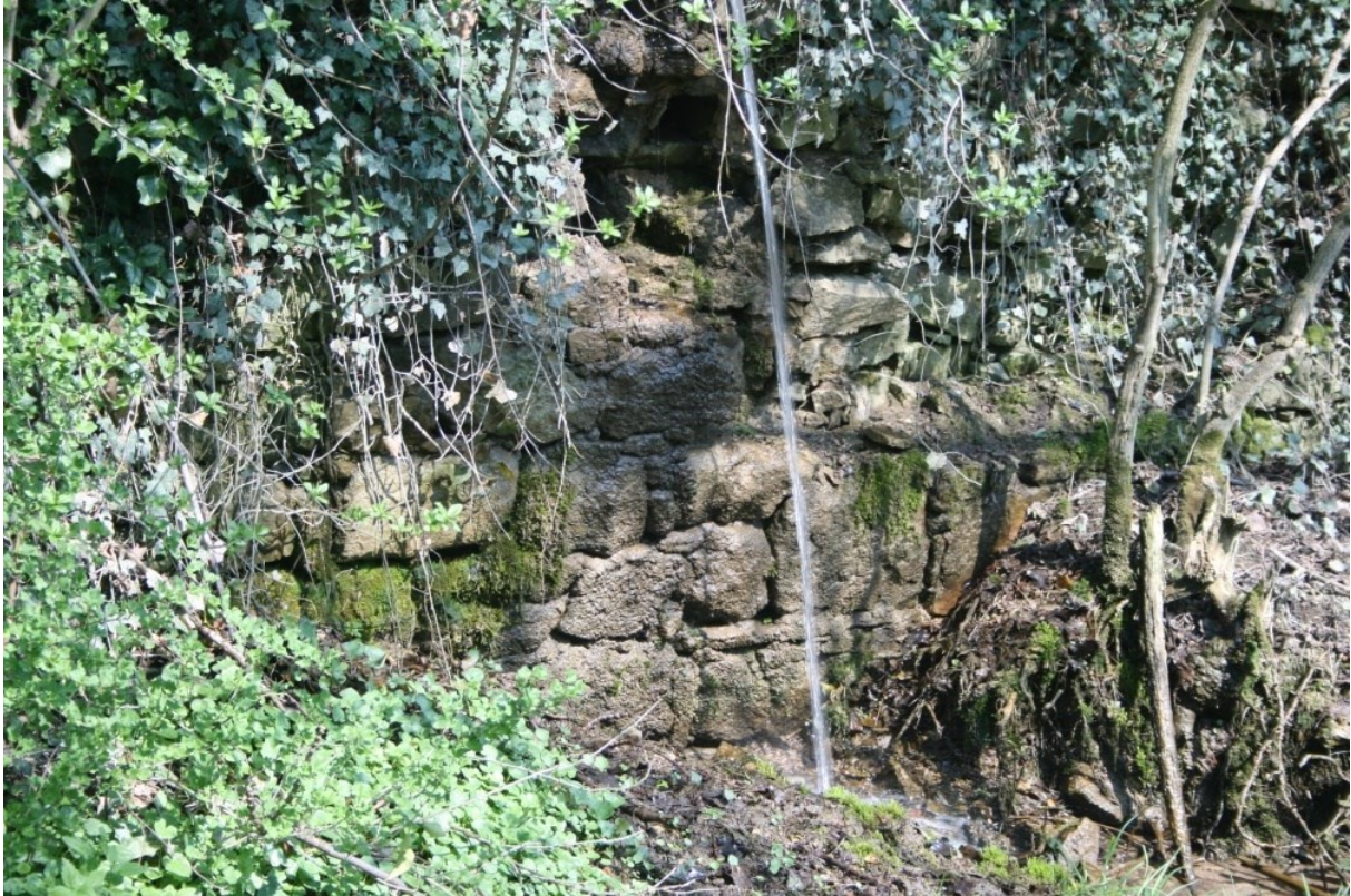
Abb.6: Detail der Südmauer
