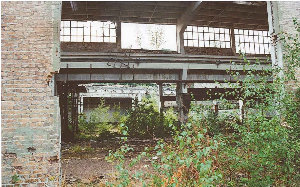
Abbildung 15: Werkhalle der ehemaligen Panzerfabrik TRZ HADŽIĆI
