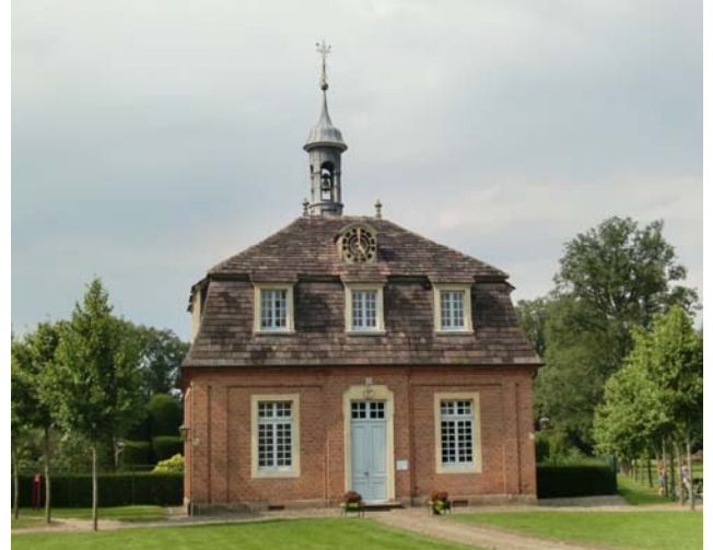
Abb. 186 CB Eingang zur Schloss- und Klosterkirche. Dieser Pavillon unterscheidet sich nur durch den Glockenturm von den anderen sieben Pavillonbauten.
