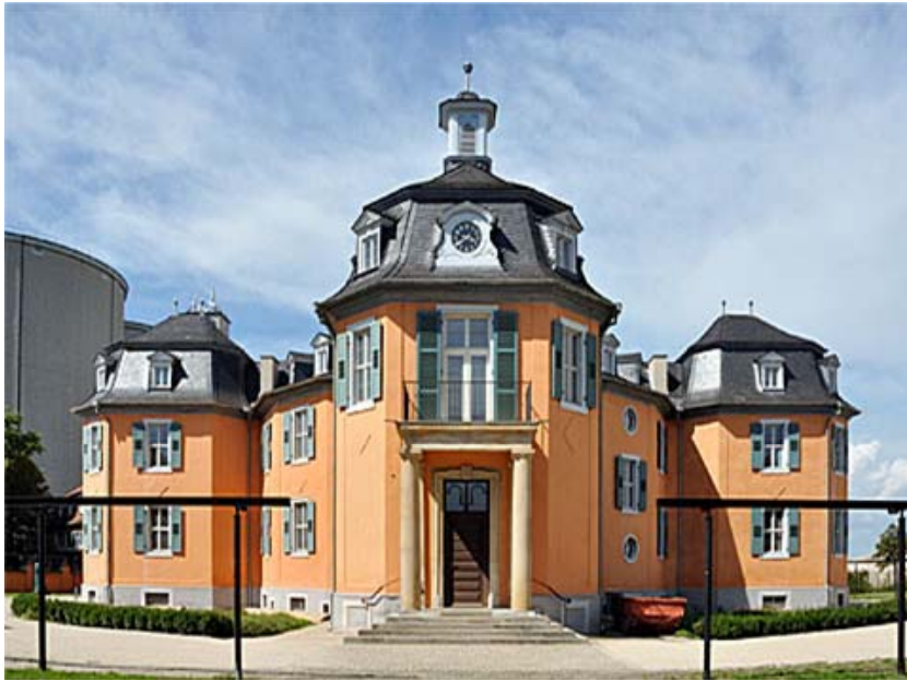
Abb. 124 Waghäusel: Eremitagenpavillon (renoviert) (links Bauten der Zuckerfabrik, die erhalten bleiben sollen)
