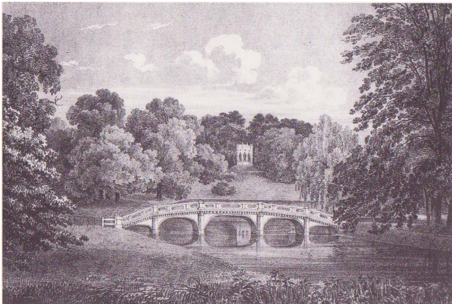
Abb. 50 Stich George Frederic Prosser, 1828, Brücke und gotischer Pavillon
