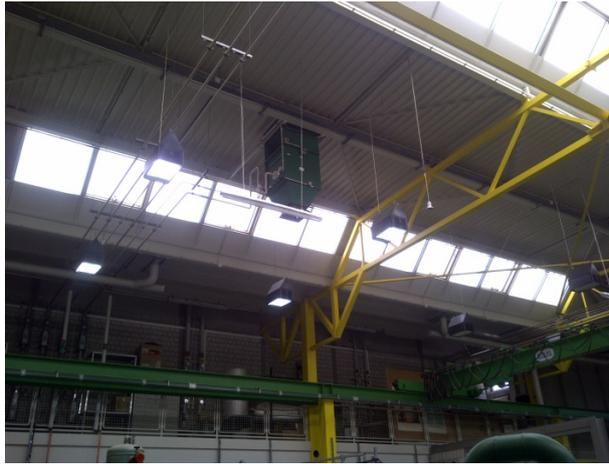
**Abbildung 4:** Wärmetauscher mit Gebläse
