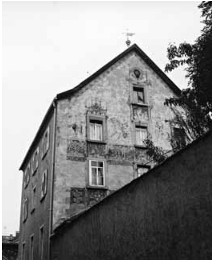
Die frühere Johanniskapelle von der Metzgerstraße aus.
