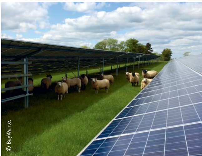
ABBILDUNG 1: Bodennah installierte Photovoltaik-Freiflächenanlagen (PV-FFA) kombiniert mit extensiver landwirtschaftlicher Tätigkeit zwischen den PV-Modulreihen. Traktoren können nur zwischen, aber nicht unter den Modulen fahren.
