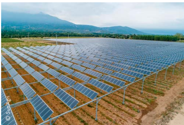
ABBILDUNG 2: Hochaufgeständerte Agri-PV-Technik mit Schutzfunktionen für die landwirtschaftliche Tätigkeit unterhalb der Modulreihen. Folienregenhäuben wie oben rechts oder Hagelschutznetze wie unten rechts können ersetzt werden; landwirtschaftliche Fahrzeuge können auch unter den Anlagen verkehren. Das Landschaftsbild verändert sich gegenüber bereits von Folien- und Hagelschutzsystemen überprägten Flächen kaum.
