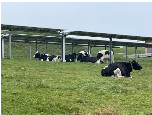
Abbildung 4-4: Kühe weiden unter einer hochaufgeständerten Agri-PV-Trackeranlage (Quelle: Zimmermann PV-Stahlbau)
