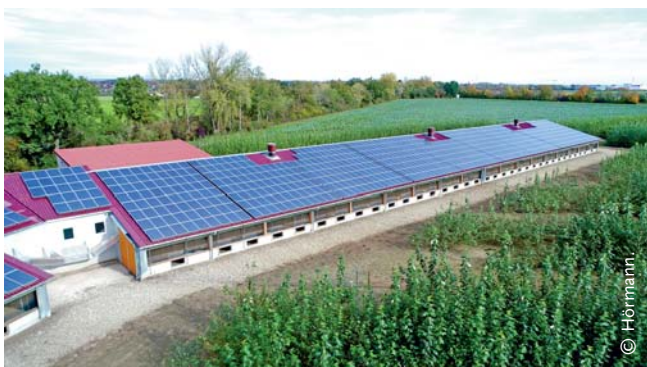
ABBILDUNG 3: Dachintegrierte PV-Technik auf Stallungen (links) und Gewächshäusern (rechts).
