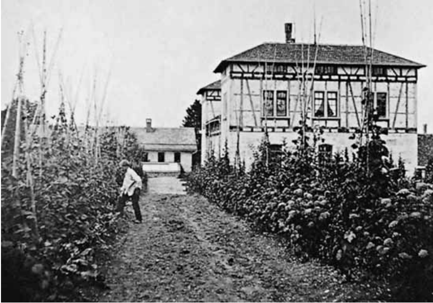
Blick von Ost nach West auf das Institutsgebäude. Im Jahr 1862 hat es nur ein Obergeschoß, erst 1869 erhält es ein zusätzliches Stockwerk.
