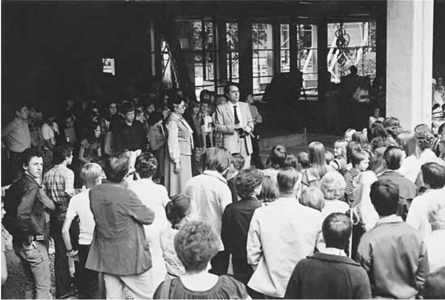
Abb. 32: Oberbürgermeister Dr. Oechsle und Schulleiterin Dr. Ziegler beim Richtfest im Foyer des Neubaus an der Bismarckstraße 55 im Jahre 1979.
