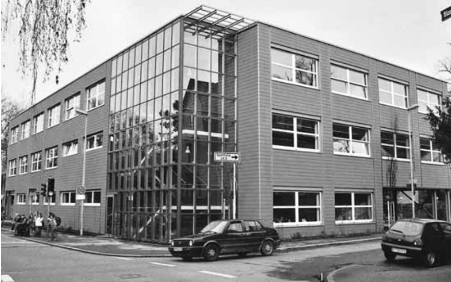
Abb. 33: Der seit dem Schuljahr 2002/2003 in Gebrauch genommene Erweiterungsbau des Isolde-Kurz-Gymnasiums brachte der Schule elf neue Unterrichts- und Fachräume sowie großzügige Nebenräume. Für die Stadt Reutlingen entstand eine städtebaulich markante Straßenkreuzung an der Ecke Bismarck-/Urbanstraße. Bis 1977 stand etwa an derselben Stelle ein repräsentativer Industriebau der Firma Lamparter.
