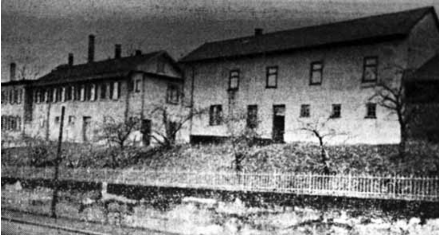
Ehemalige Wohngebäude der Schüler längs der Alteburgstraße vor ihrem Abbruch 1980.
