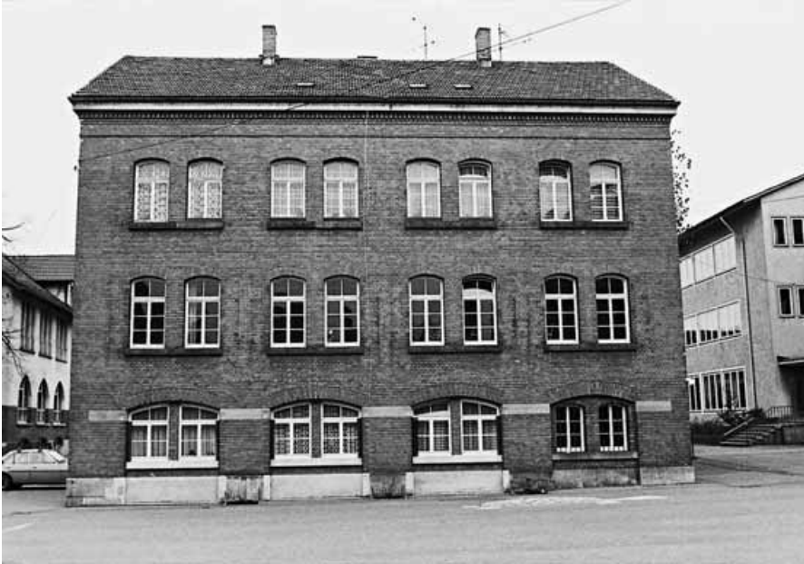
Abb. 28: Der sog. „Zentralbau“ (Planie 25 a) im Innenhof des Schulgeländes wurde vom Isolde-Kurz-Gymnasium 1973 bis 2002 für 4 Klassen als Schulhaus genutzt. Im Erdgeschoß befand sich eine Wohnung des Hausverwalters.
