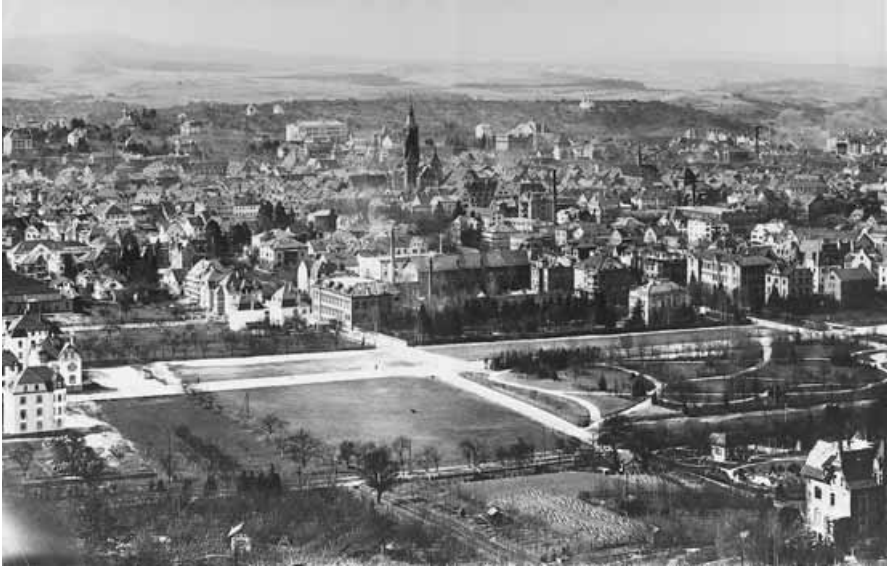
Abb. 9: Reutlinger Oststadt im April 1911. Das Schulgebäude von 1896 lag im „Neubaugebiet“, d. h. in der im 19. Jahrhundert kontinuierlich erschlossenen Oststadt an der Planie (rechter Bildrand Mitte). Die Planie mündet in den 1902 von Dr. Lucas neu angelegten Stadtgarten. Im Geviert Planie/Bismarck-/Urban-/Charlottenstraße liegt gegenüber dem Schulgebäude das Fabrikgelände der seit 1885 bestehenden Firma Gustav Lamparter, auf dem sich seit 1980 das Hauptgebäude des Isolde-Kurz-Gymnasiums samt dem Erweiterungsbau von 2002 befindet.
