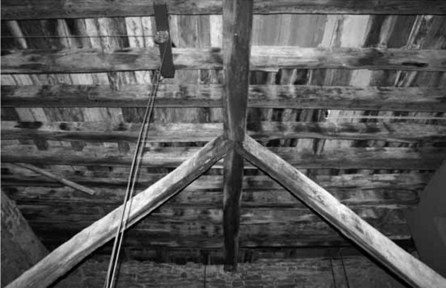
Abb. 22: Das als Plattform des Turmaufsatzes dienende Deckengebälk von 1330 (d) über dem 4. Obergeschoss (Blick nach Westen). Deutlich sichtbar ist die Brandrötung des älteren Mauerwerks bis an die Mauerkrone und der abgesprengte Querunterzug eines späteren Umbaus (16. Jh.?).
