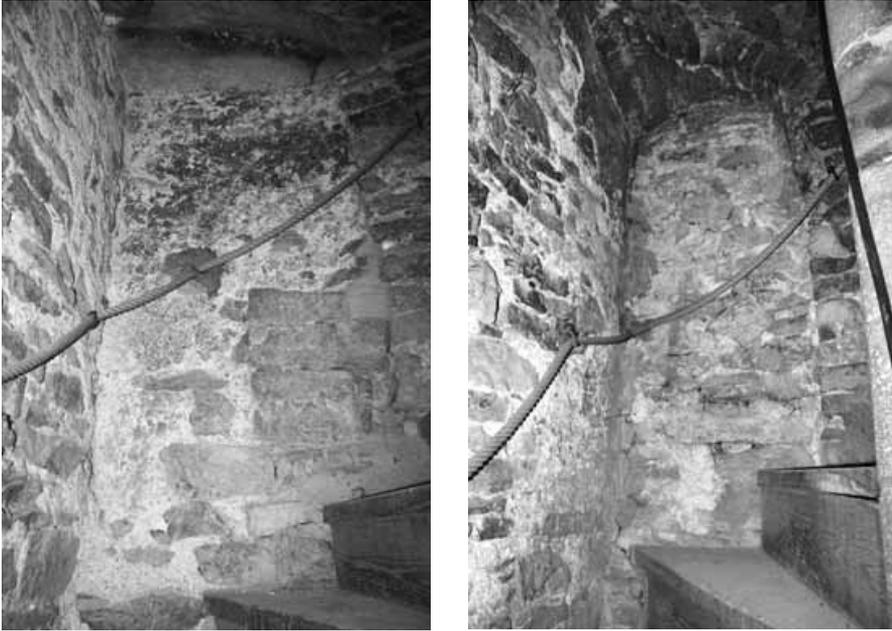
Abb. 10a und 10b: Die beiden Türöffnungen zum Wehrgang der ehemals nördlich angrenzenden Stadtmauer: die ursprüngliche untere Türöffnung mit flachem Sturz (a), die jüngere (b) mit Backsteinüberwölbung (Umbau 1527–31?).
