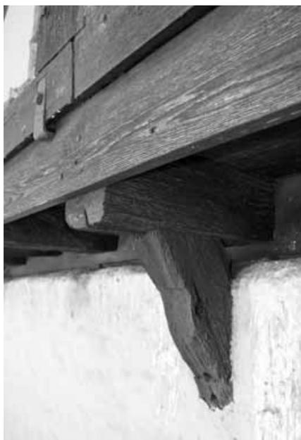
*Abb. 23:* Original erhaltene Stützstrebe (Bug) des Turmaufsatzes von 1330 an der Nordseite. Deutlich erkennbar sind die hölzernen Blendbohlen, mit denen 1909/10 und um 1950 die älteren Hölzer verkleidet oder teilweise ersetzt wurden.
