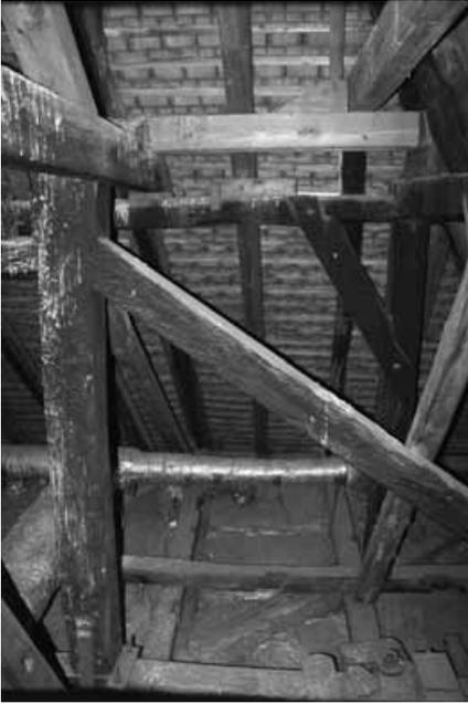
Abb. 33: „Jüngere“ Dacheinbauten: im Hintergrund stehendes Stuhlgebäude mit Stuhlständer und Kopfband von 1375 (d), im Vordergrund abgestrebtes Hängholz des westlichen Sprengbundes von 1527 (d).
