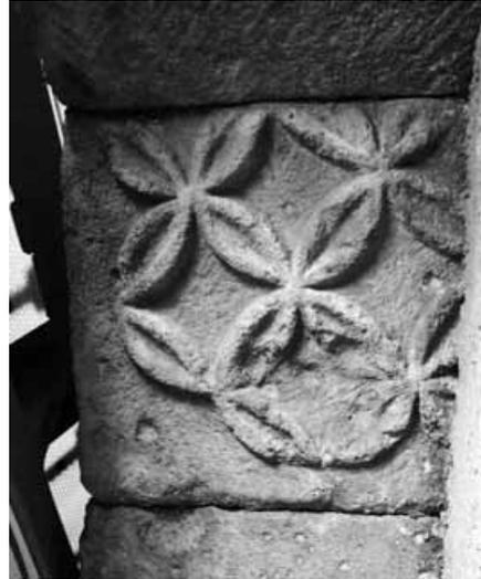
Abb. 13 a und 13 b: Südliche Nische mit Eckbuckelquadern und Reliefstein im Spitzbogen.
