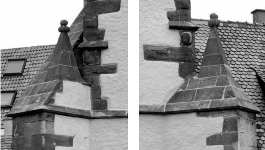
Abb. 8a und 8b: 1909/10 erneuerte Fialen der Strebepeiler (Zustand 2007): a) Nordwest, b) Südwest.
