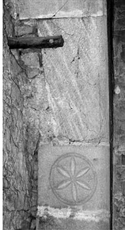
*Abb. 14a und 14b:* Westseite des 1. Obergeschosses mit hoher Spitzbogennische für das ehemalige Fallgatter. Unter dem 1277/78 (d) datierten Deckengebälk sind doppelte, wohl als Auflager für die Zugvorrichtung des Fallgatters dienende Steinkonsolen erkennbar. An der Nordseite befindet sich das Ornament einer sechsblättrigen Rosette.
