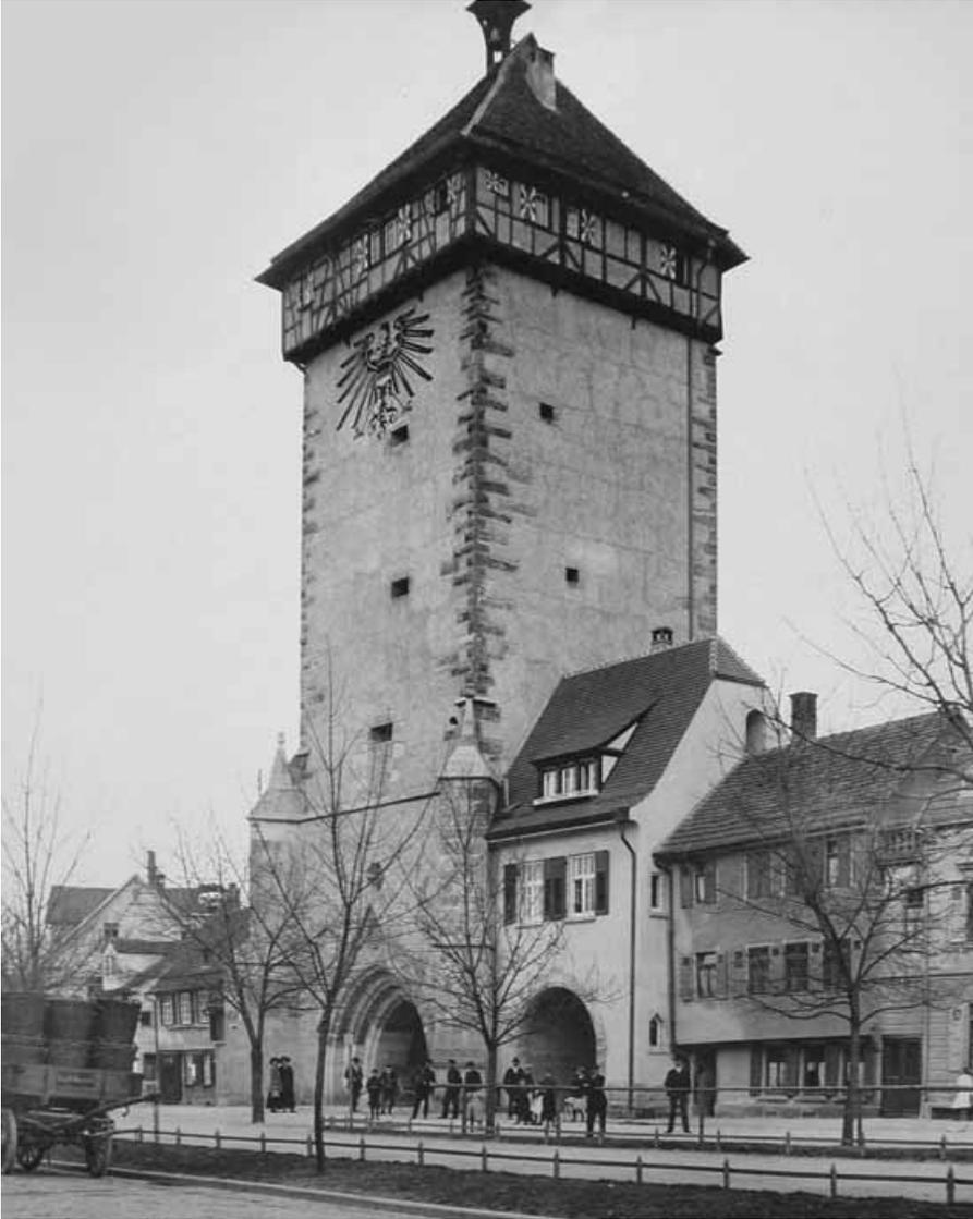
*Abb. 1:* Das Tübinger Tor von Westen nach der Renovation 1909/10 mit freigelegtem Fachwerk und dem neu aufgemalten Reichsadler.
