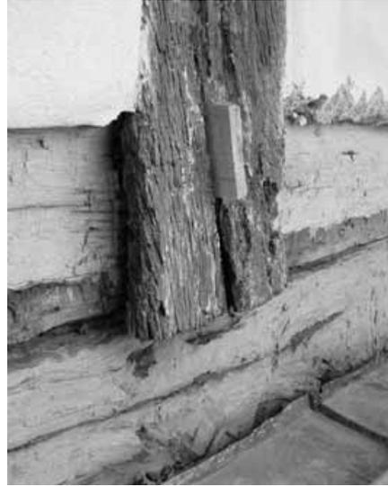
Abb. 25: Erhaltenes Ständerfußblatt an Bundständer der Ostseite (Schwelle ist zur Verkleidung mit Holzbrett um etwa 4 cm abgearbeitet).
