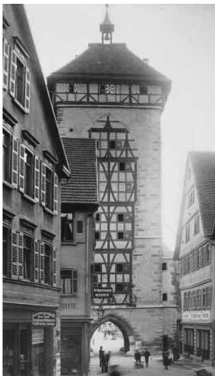
Abb. 35: Ostseite des Tübinger Tores mit der Schalenöffnung des 13. Jahrhunderts, dem Spitzbogenschluss von 1375 (?) und der Fachwerkfüllung von 1531 (d) um 1910.
