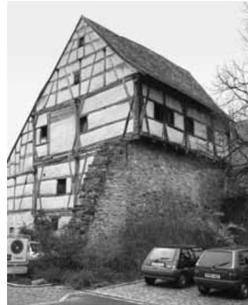
Abb. 30a–30c: Hölzerne Aufbauten auf massiven Wehrmauern: a) Schloss Gomaringen 1309 (d) und 1500 (d); b) Pfullendorf, Schoberhaus von 1358 (d); c) Weilheim an der Teck, Ostflügel des ehemaligen Stadtschlusses von 1469 (d).
