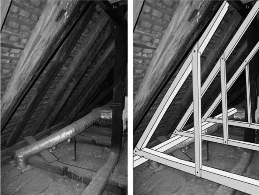
Abb. 28: Dachkonstruktion nach Nordwest und Bauteile 1330 (Rekonstruktion).
