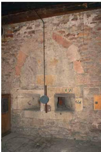
Abb. 16: 1528 (i) zu einer Geschützscharte umgestaltete Spitzbogennische an der Westseite des 2. Obergeschosses. Deutlich erkennbar ist die starke Brandrötung der älteren Wandteile, die an der Vermauerung der Nische fehlt.
