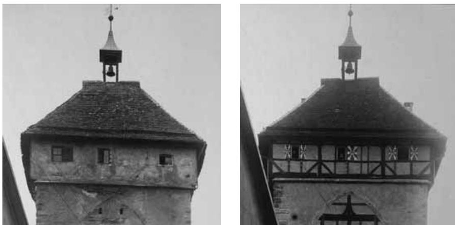
Abb. 21a und 21b: Ostseite des Turmaufsatzes vor und nach der Freilegung des Fachwerks bei der Renovierung 1909/10.
