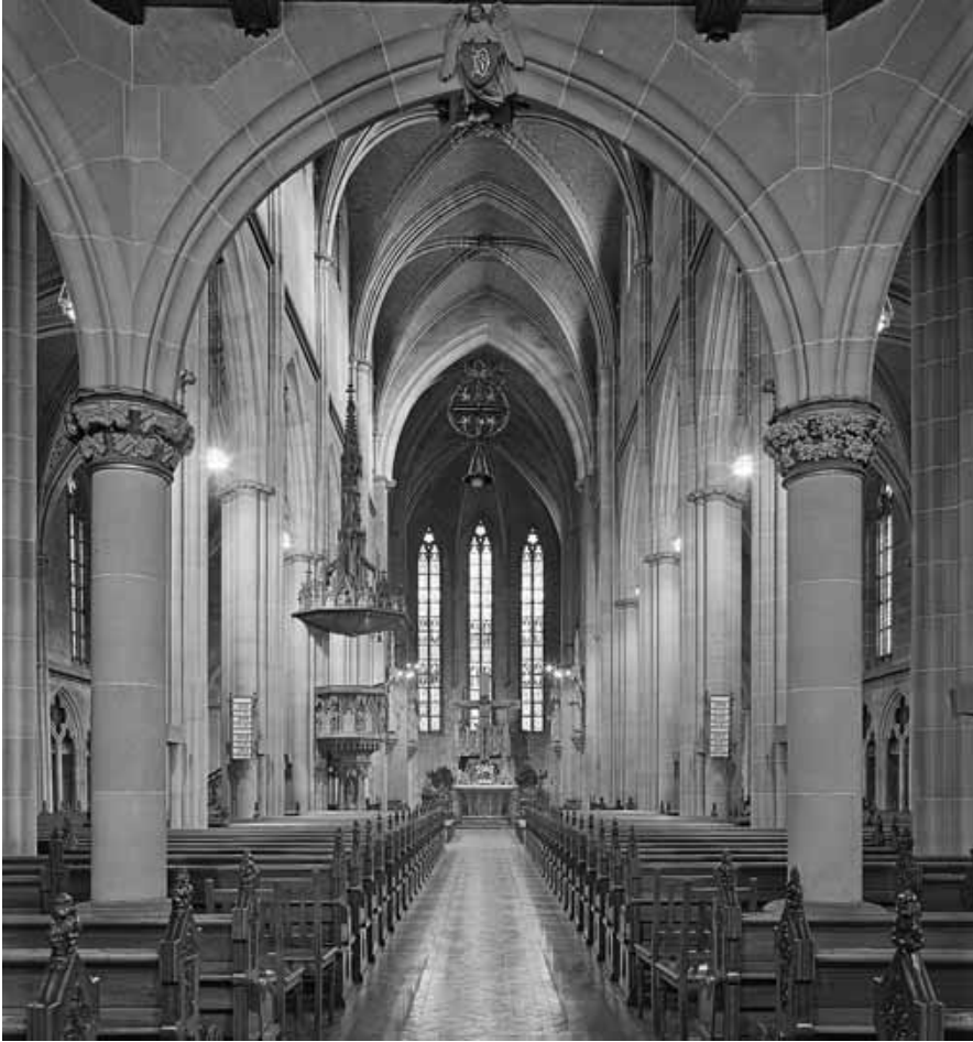
Abb. 16: Die Marienkirche, Innenraum nach Osten, Aufnahme von 1966.
