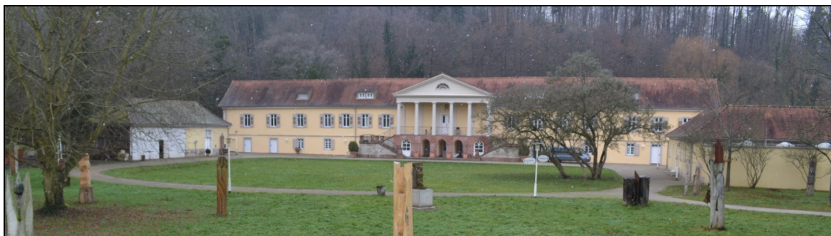
Abb. 38 Gaggenau-Bad Rotenfels, Schloss Rotenfels mit Südlichem und Nördlichem Nebengebäude, Baubestand 2015.
