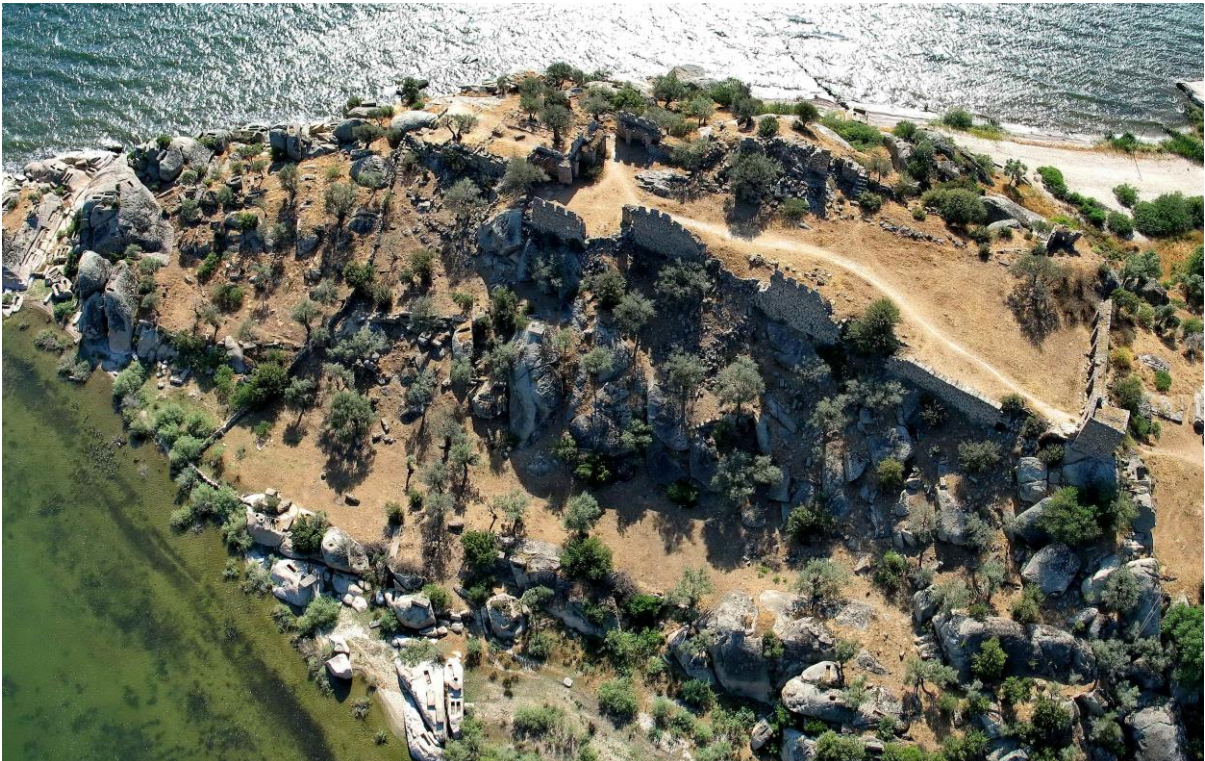
Abb. 94: Allerdings stehen hier nur noch die Außenmauern, das Innere der Seeburg, die manche für den Bischofssitz von Herakleia halten, ist weitgehend leer
