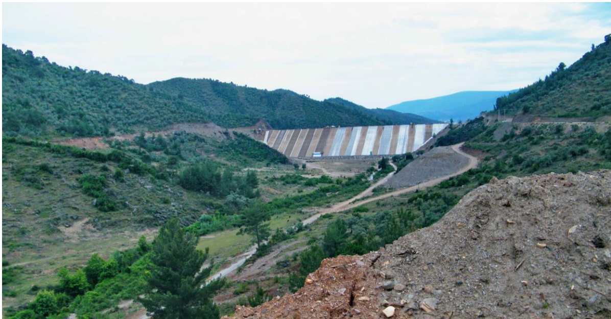
Abb. 121: Talsperren-Baustelle im Derince-Tal im Mai 2014
