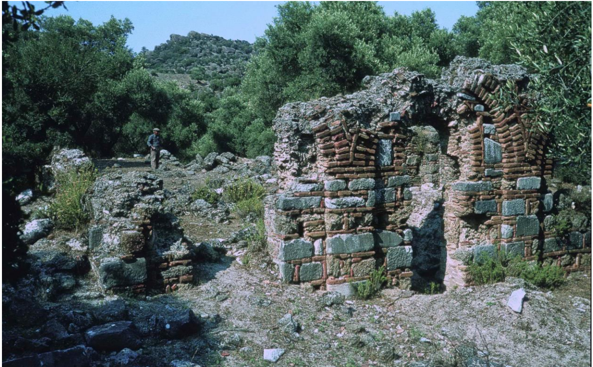
Abb. 84: Reste der letzten Bebauungsphase des Klosters Kiliselik. Die Art des Mauerwerks ist eng verwandt mit dem der Kirchen von Yediler, Kahve Asar Adası und İkiz Ada.
