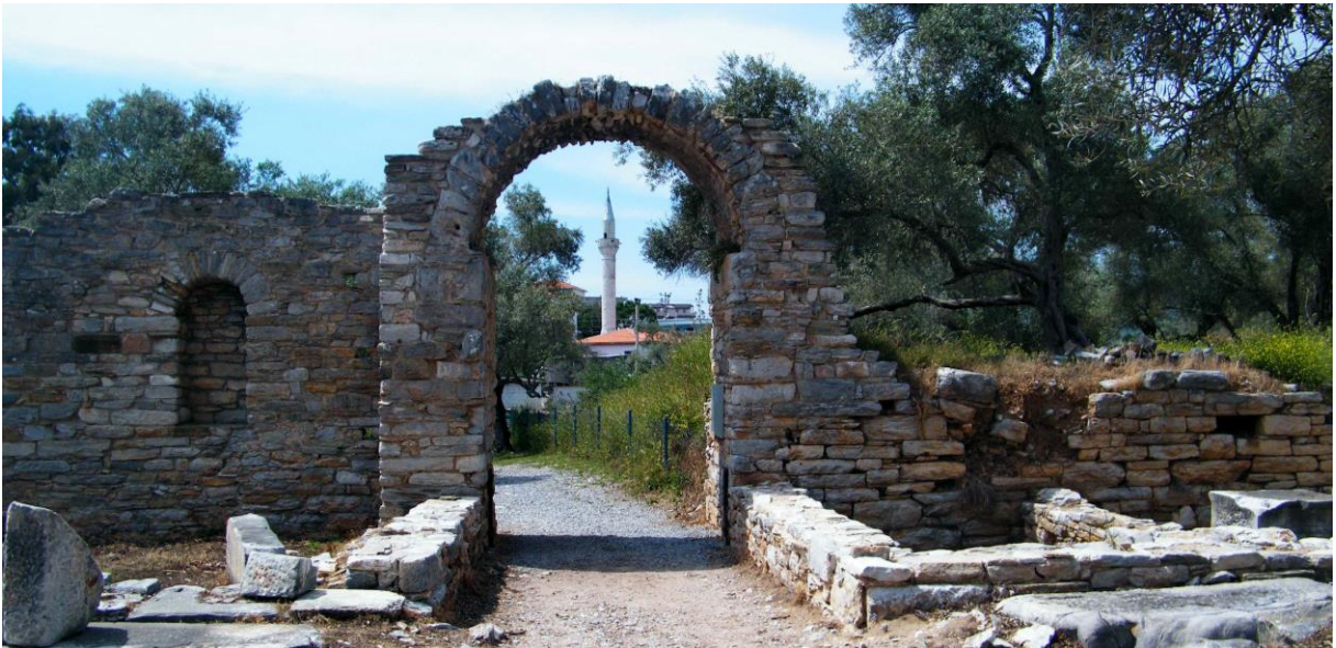
Abb. 141: Ein Tor führt von Norden zu einer von Säulen umgebene römische Agora.
