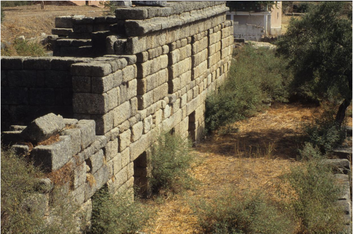
Abb. 53: Die umfangreichen Substruktionen an der Südseite der Agora wurden als zweigeschossiger Magazinbau mit einem vorgelegten Korridor gestaltet, über dem sich eine zweischiffige Halle erhob.
