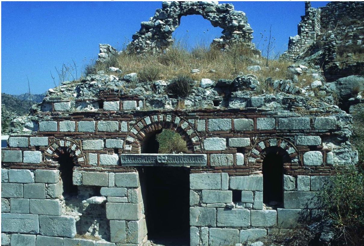
Abb. 79: Die Tonnengewölbe der dreischiffigen Basilika auf der „Klosterinsel“ mit jeweils drei Arkaden über den Pfeilern endeten in einer dreiseitig ummantelten Apsis. Der ungewöhnliche Architekturtyp des durch Blendnischen und Kästelmauerwerk verzierten Mauern verweist die Kirche ins 13. Jh..
