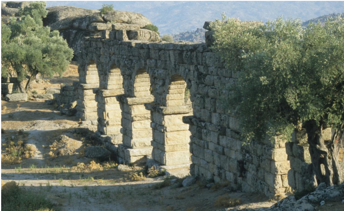
Abb. 149: Auf windungsreichem Anstieg erreicht man oberhalb von Karpuzlu bei einem etwa 45 Meter langen Teilstück eines alten Aquädukts die Höhen der antiken Oberstadt.
