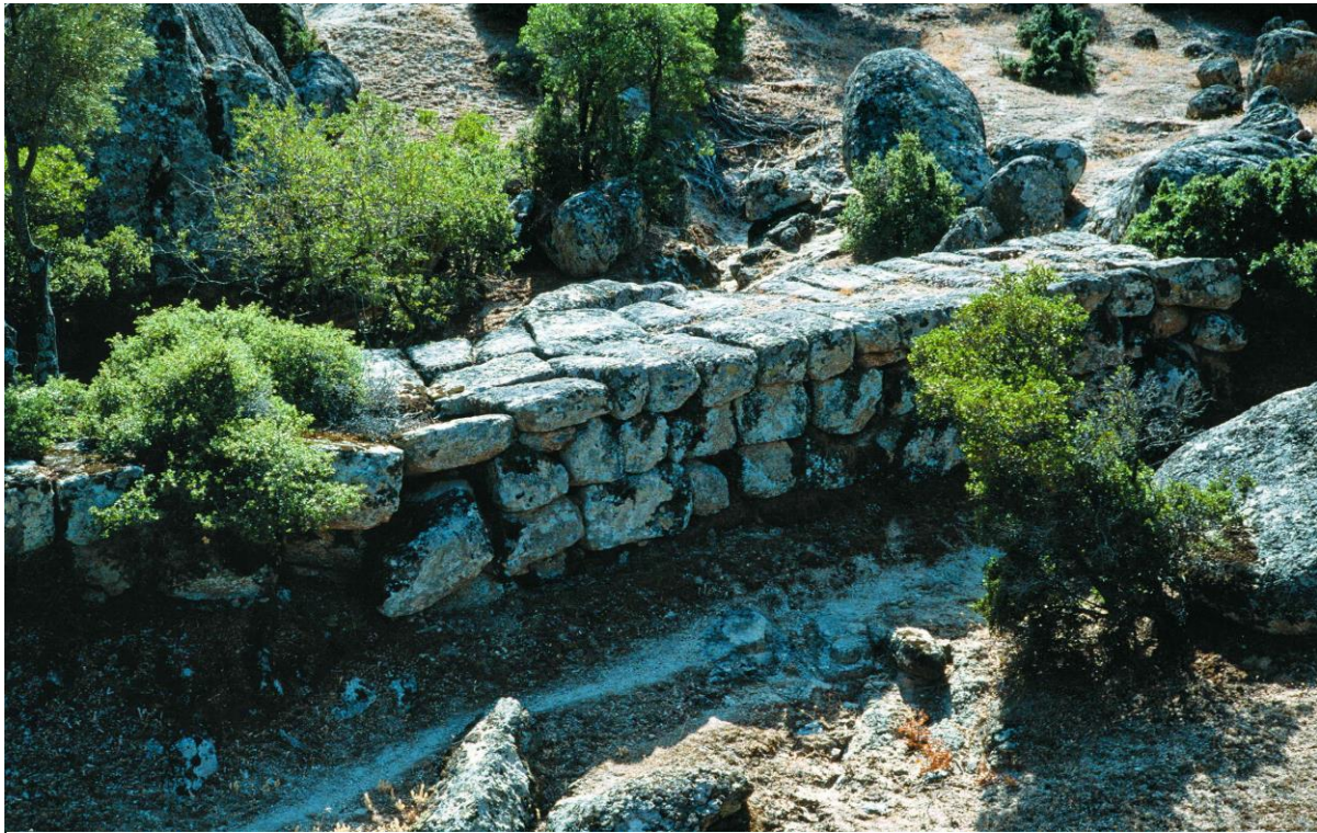
Abb. 216: Das obere Straßenpflaster besteht aus großen, bis zu 70 cm starken Gneisplatten, die die gesamte Wegbreite einnehmen können und von denen oft nur noch Randsteine erhalten geblieben sind.
