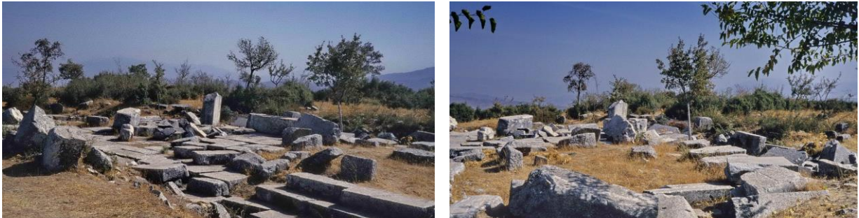
Abb. 138 a/b: Innerhalb der Mauern von Amyzon findet man ein paar nicht identifizierbare Gebäudereste, Relikte der Agora und eines Nymphäums sowie große unterirdische Gewölbekammern.
