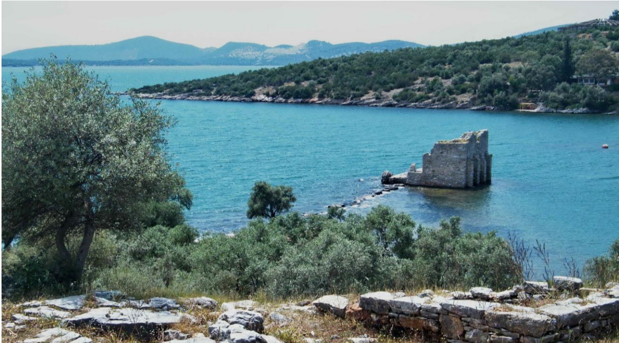
Abb. 144: Verschiedene Ruinen ragen noch aus dem Wasser: Leuchtturm und Wachttürme sind im Hafenwasser versunken.
