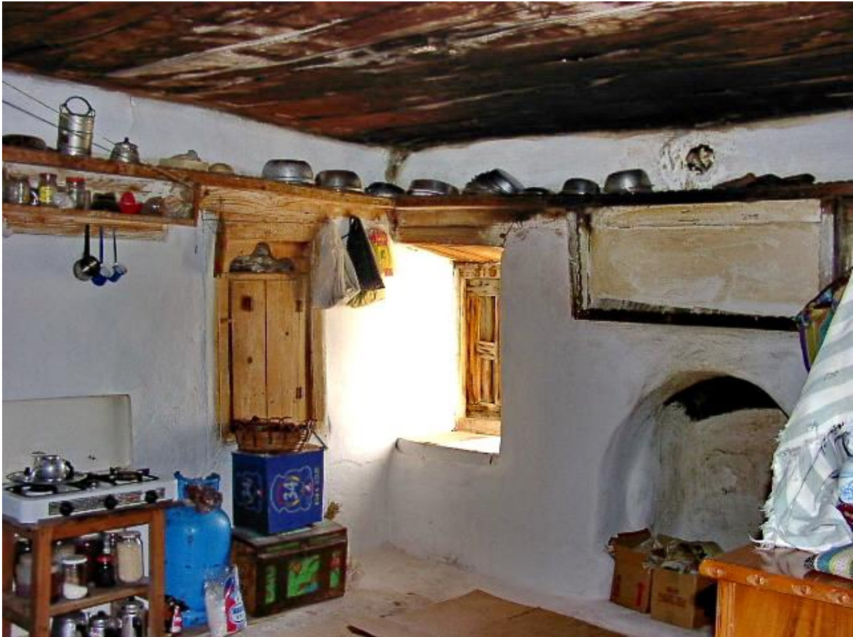
Abb. 61: Horizontale Holzprofile oberhalb der Fenster- und Türstürze dienen als Zierleisten oder Ablagebretter. Wandnischen mit raumseitig aufschlagenden Holztürchen bieten zusätzlichen Stauraum.
