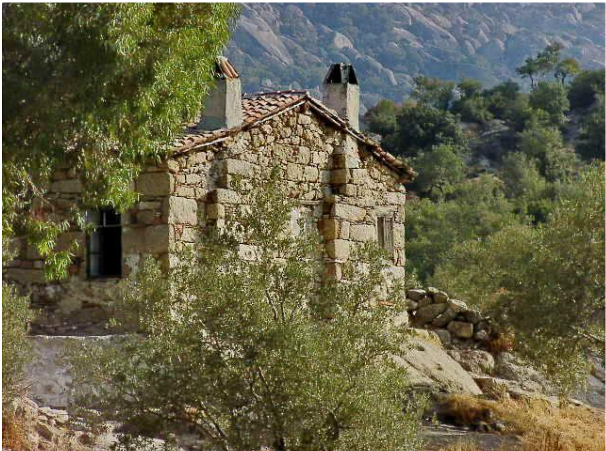
Abb. 59: Kapıkırı, Haus 63, zweischaliges Mauerwerk aus Quadern und Bruchstein, Satteldach mit Ziegeldeckung. Kamine springen aus der Mauerflucht
